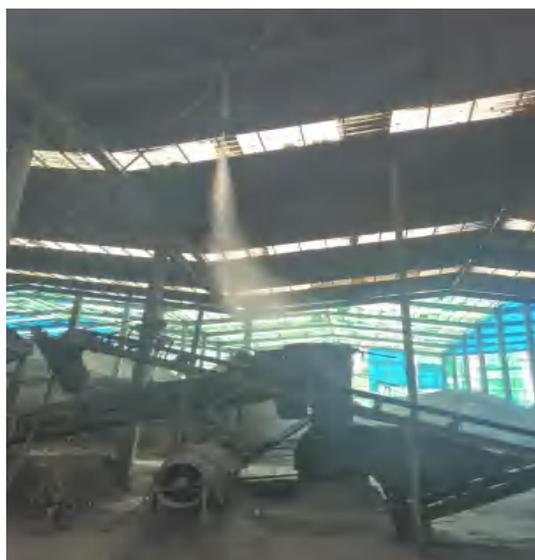
图 5-3 破碎车间上方设置的喷淋设施
