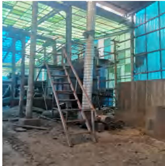
图 5-2 破碎车间筛分机旁设置的除尘器
