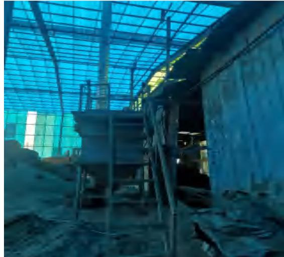
图 5-6 破碎车间对辊机旁设置的除尘器
