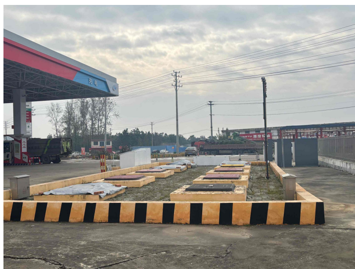
图 2-8 加油站储罐区照片
